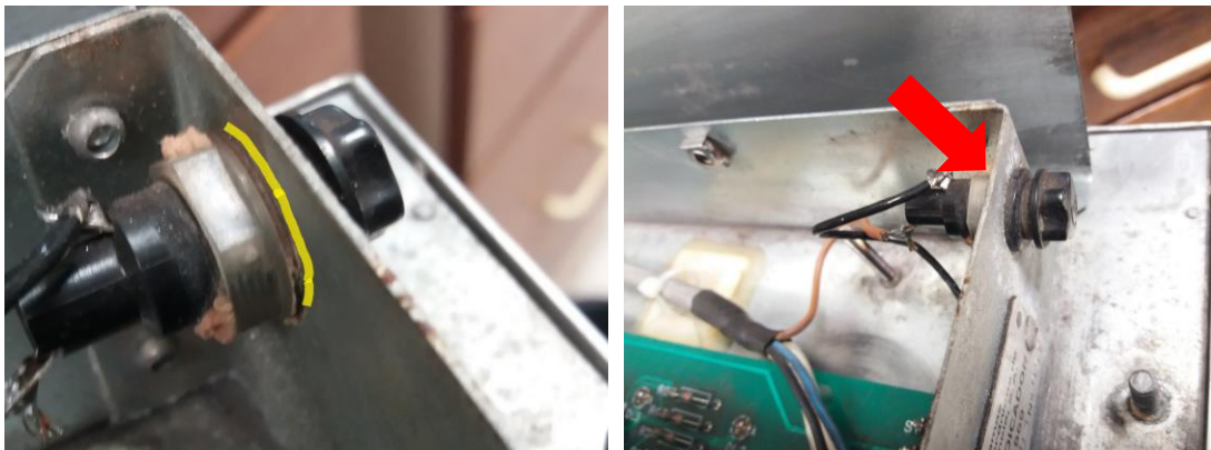
Imatge 4- Vista de la zona on va muntat l'element.
